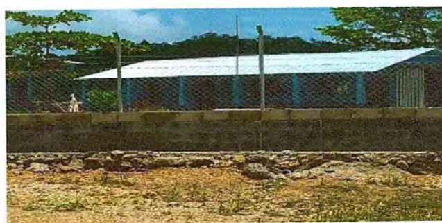
Foto 3: circulacion mura perimetral.
