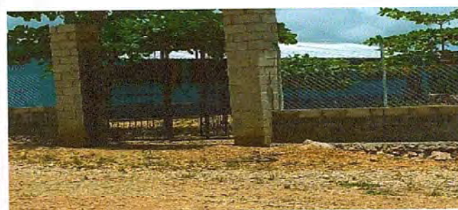
Foto 5: porton de ingreso nuevo.
