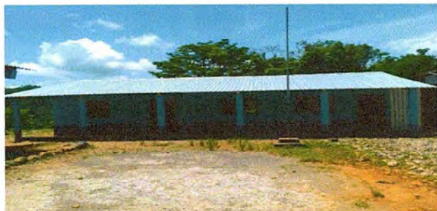
Foto1: finalizacion del cubierto de láminas.
