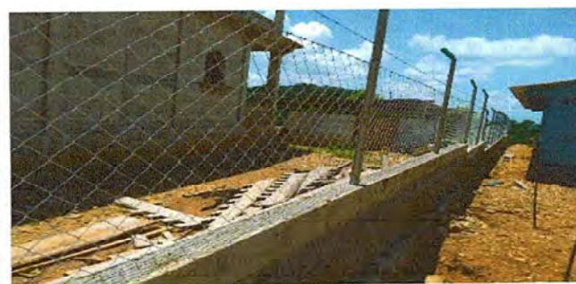
Foto 4: finalizacion de colocacion de tubos gavanizado, mallas y alambres de espiga.
